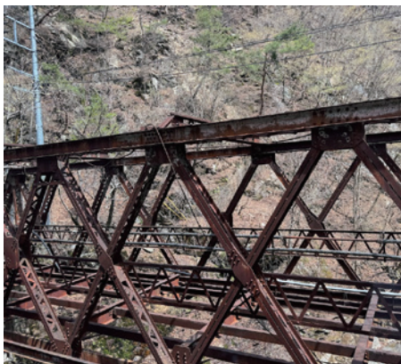
坑道トロッコ線路跡
